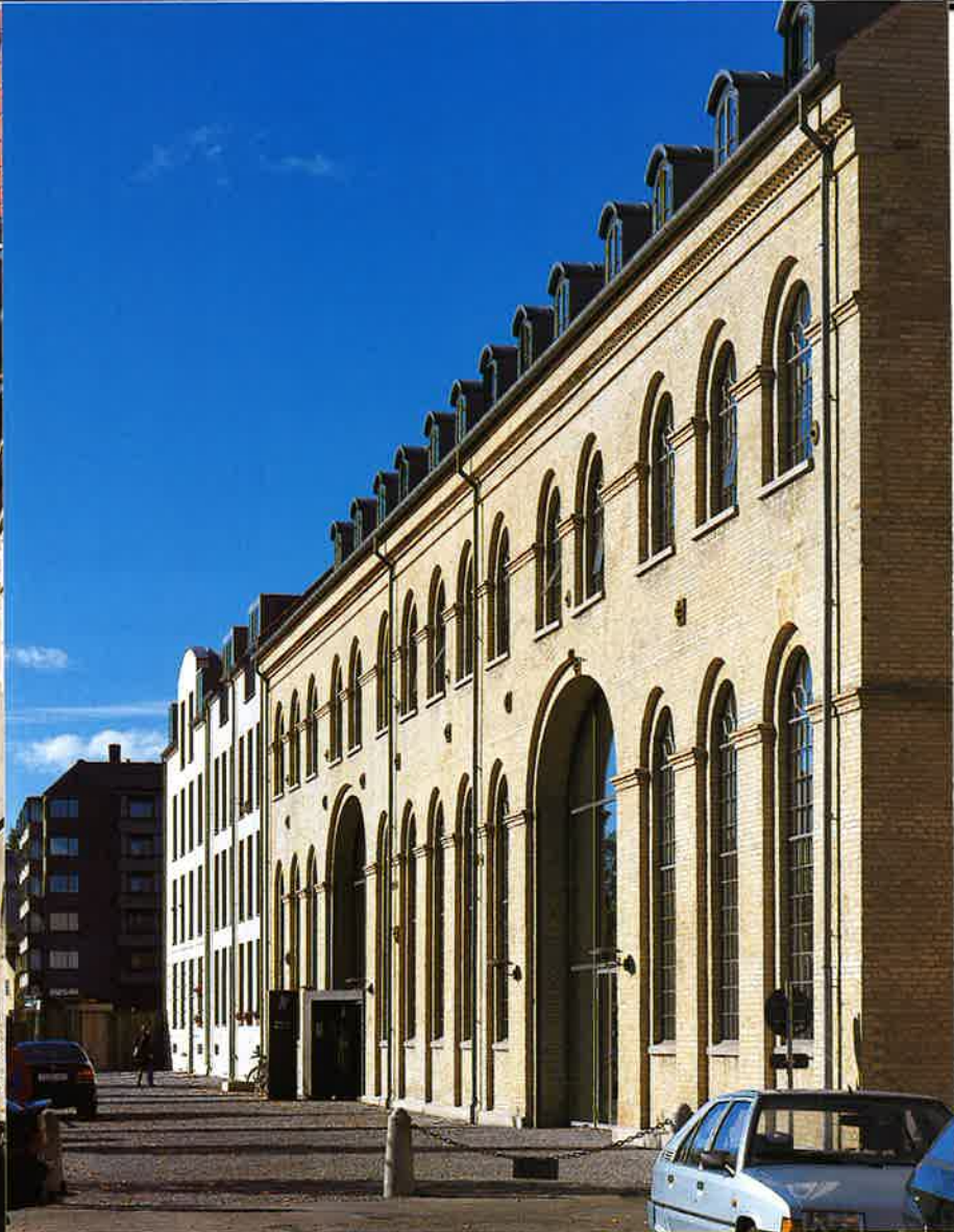
Kantorencomplex in hergebruikt industrieel gebouw in Christianshavn, Kopenhagen
