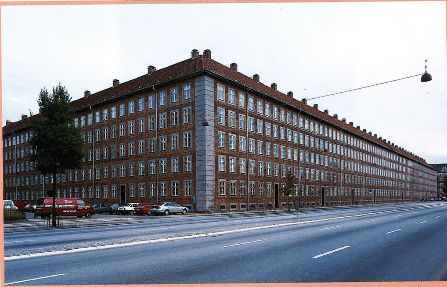
Kolossaal woningencomplex 'Hornbækhus' met gemeenschappelijk binnenterrein, Kopenhagen
